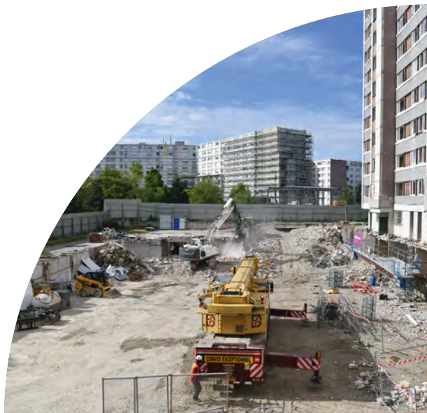
Démolition de l'immeuble B4 - quartier Franc-Moisin
