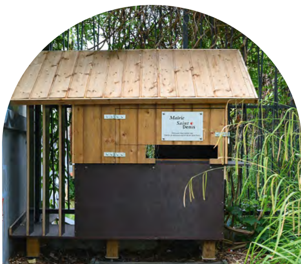
Abris à chats - Square Diderot
